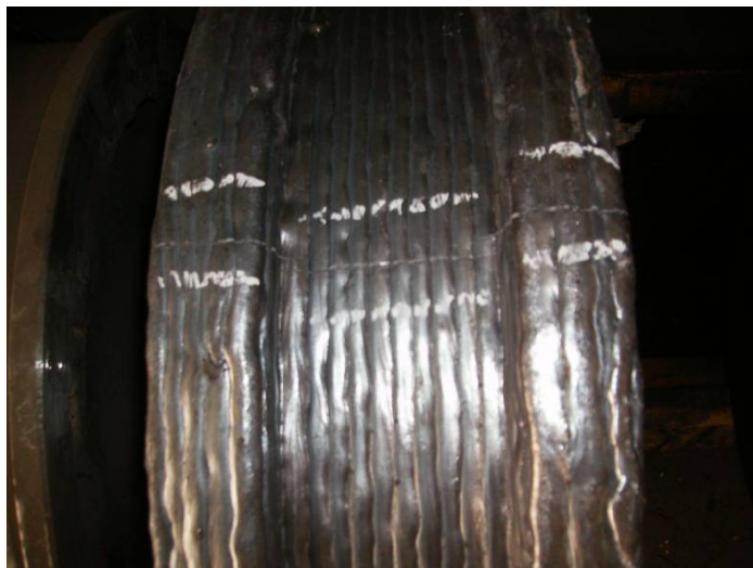
Slika 6. Prslina po celom preseku točka neposredno posle navarivanja II sloja
